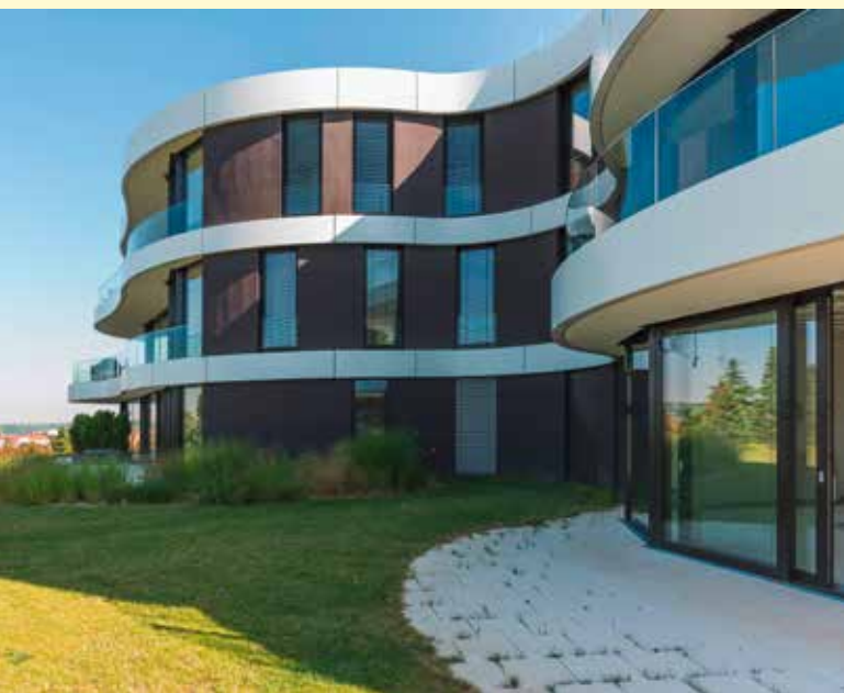
In der Wohnanlage sorgt seit Juli 2014 ein Dachs für die Energieversorgung. Das Mini-BHKW kommt auf 6.000 Betriebsstunden pro Jahr.
